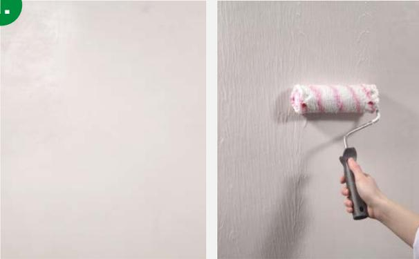
Die zu armierende Fläche gemäß VOB, Teil C, DIN 18363 bzw. BFS-Merkblättern vorbereiten. Anschließend Vlies- und Gewebekleber auftragen, rollen oder spritzen.
