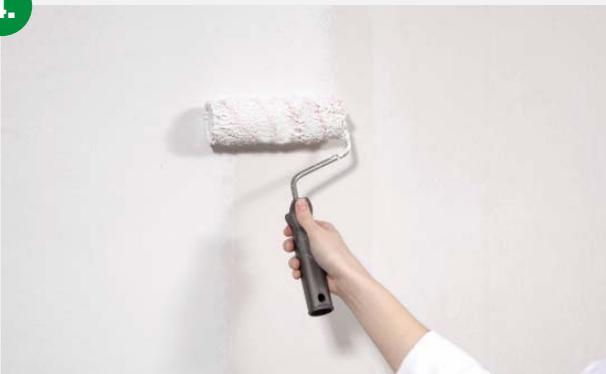
Nach guter Durchtrocknung der Vliesverklebung (mind. 12 Stunden) erfolgen die Zwischen- und Schlussbeschichtung je nach Oberflächenanforderung im System.
